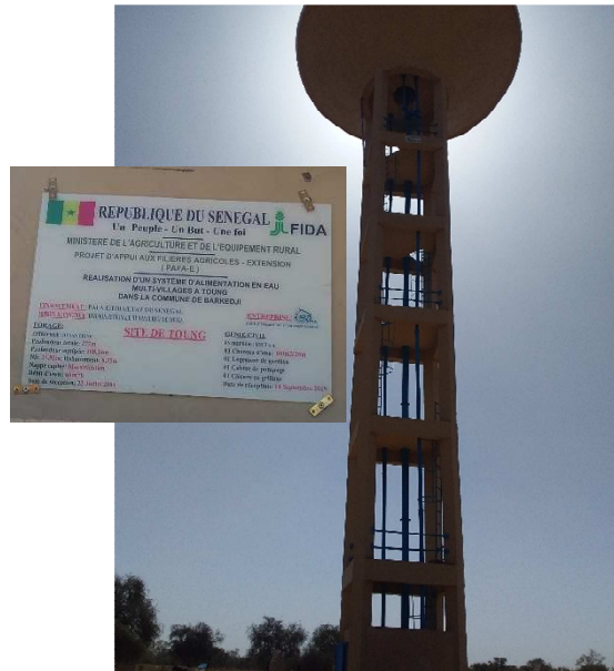
Image 7 - château d'eau de l'UP de Toung
