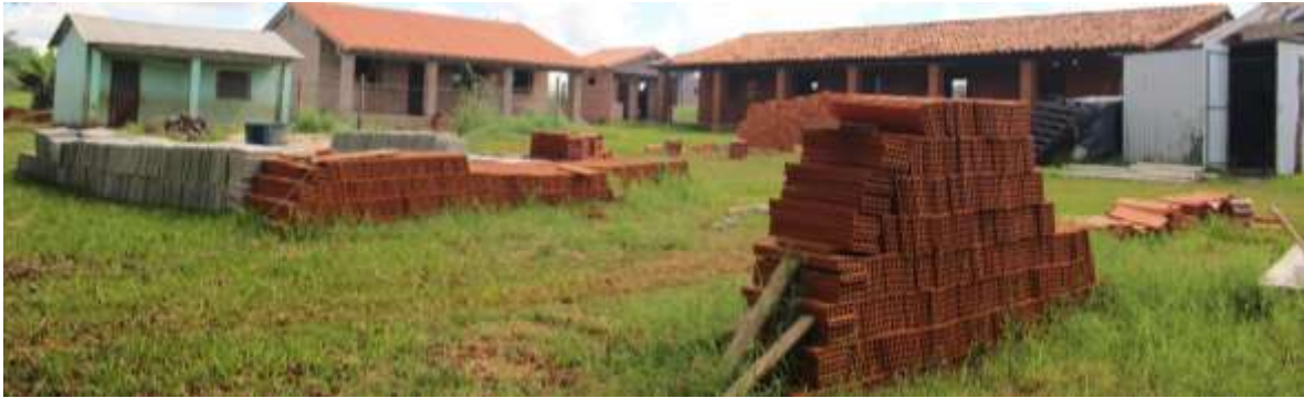
Fotografía 5. Construcción de la nueva escuela en material.
