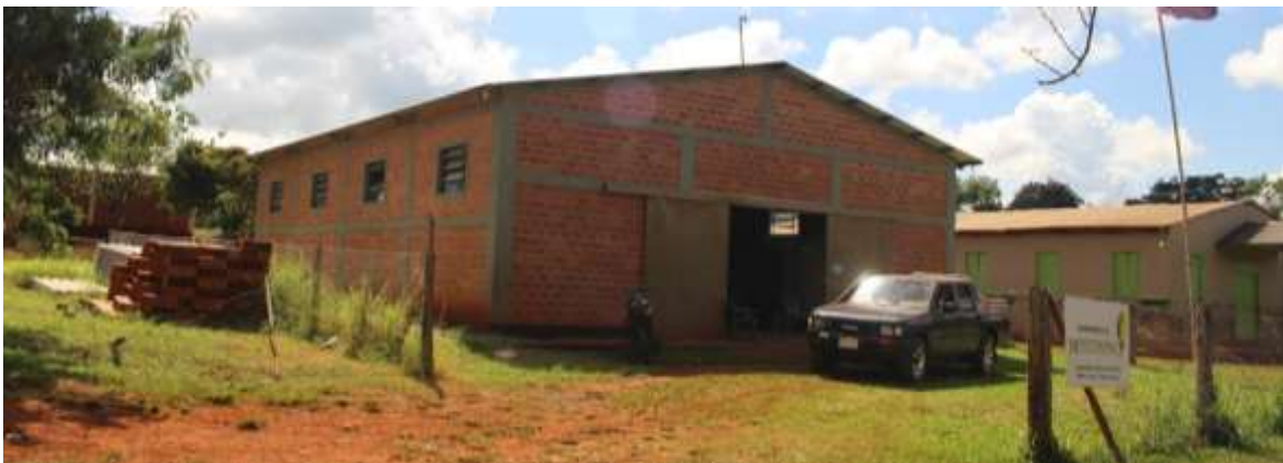
Fotografía 6. Local comunitario construido a través del Plan de microcapitalización.
