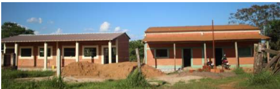
Fotografía 10. Local escolar construido por la compensación del proyecto vial.
